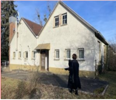
Bestandsgebäude Langhaus Westseite
